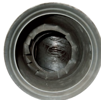
Ventilasjonskanal etter rens
